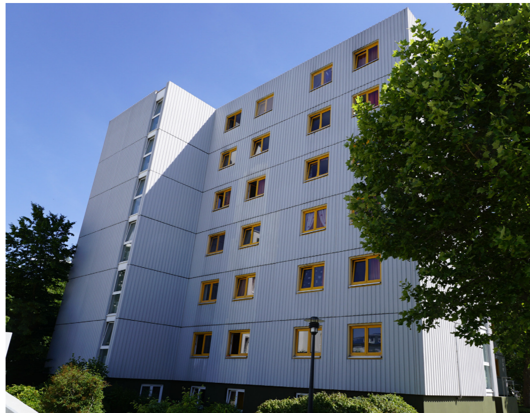
Teilabschnitt des Studentenwohnheims Pestalozzistraße in Bamberg
