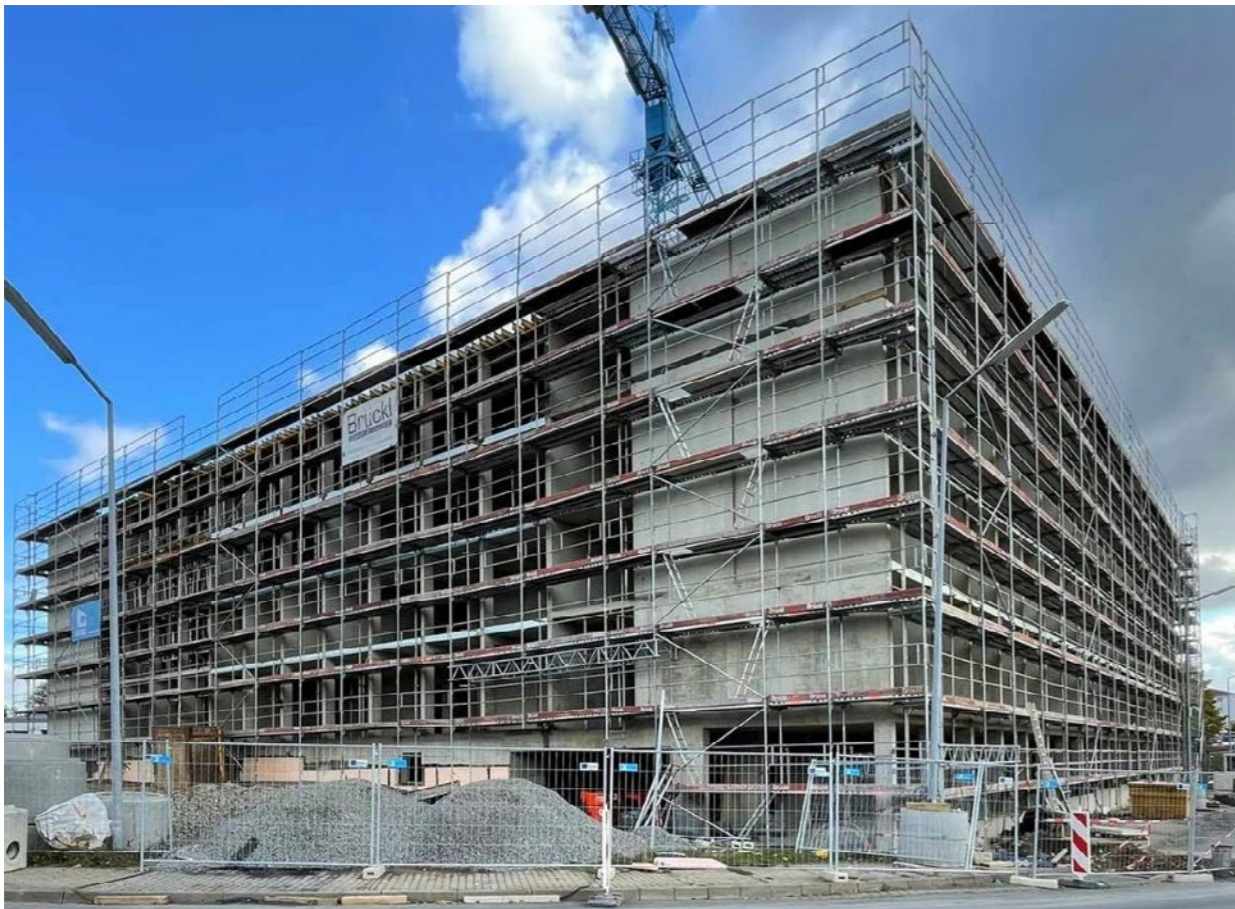
Neubau Klara-Oppenheimer-Weg, November 2021, Nordwestansicht
